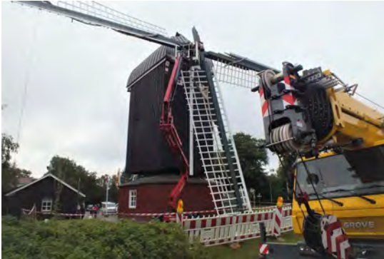
Abbildung 9 Wiederaufbau der Flügel
